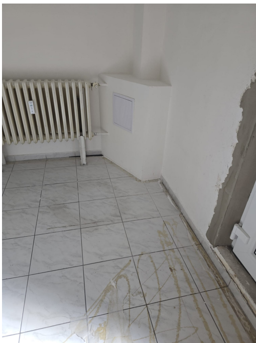
03 / Podlahová plocha u otvoru
