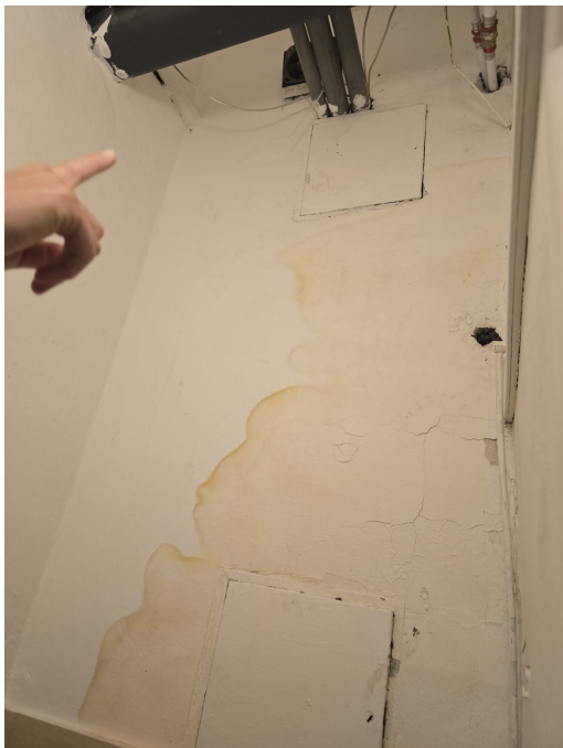
01 / Stěna v prostoru rozvodů
