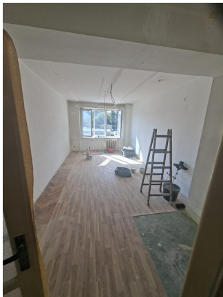
Rozsáhlejší příprava a sjednocování stěn před finální výmalbou.
