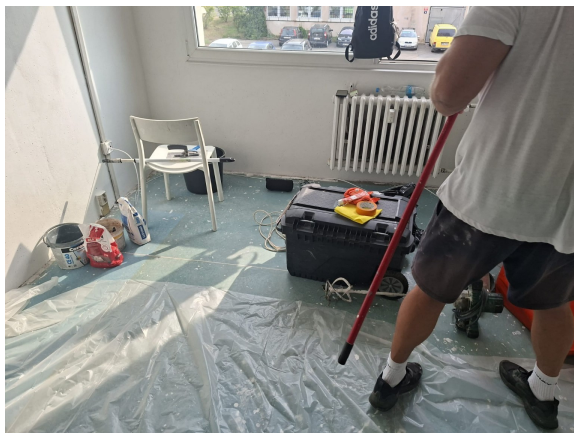
Zakrytí a příprava pracoviště při reálné zakázce Malířství24.
